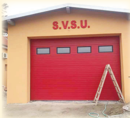
Sânmihaiu Român - clădirea remizei de pompieri
