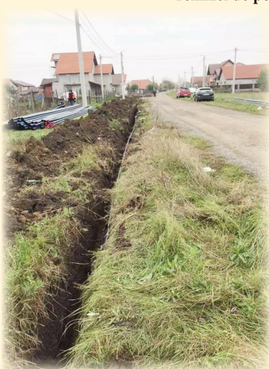
Sânmihaiu Român - extindere rețea de apă potabilă
