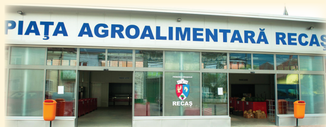
Piața agroalimentară a orașului, fațada principală
