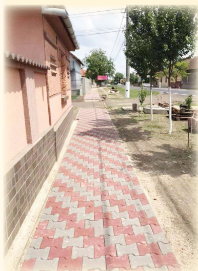
Uțvin - execuție trotuare cu pavele de-a lungul DJ 591
