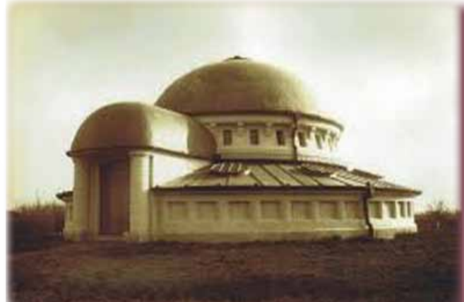
Clădire ce adăpostește un grup de foraje, din anul 1914
