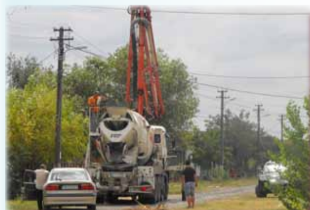
Viceprimarul comunei noastre urmărind lucrările de asfaltare
